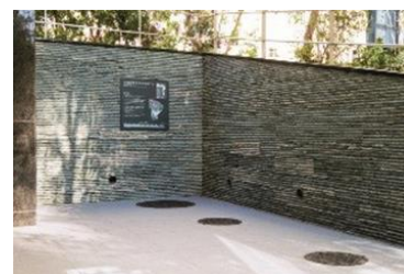
マンホールトイレ
