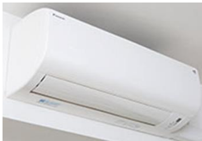
空調設備の更新
